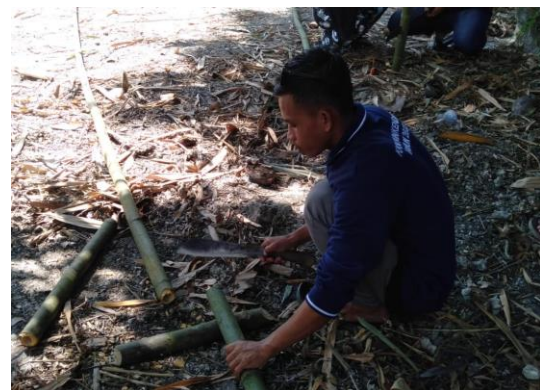
Gambar 2. Memotong bambu yang akan digunakan sebagai pagar
